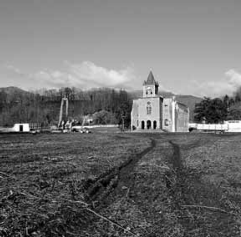
Máquinas trabajando en torno al antiguo colegio de Lekaroz. FOTO: ONDIKOL
